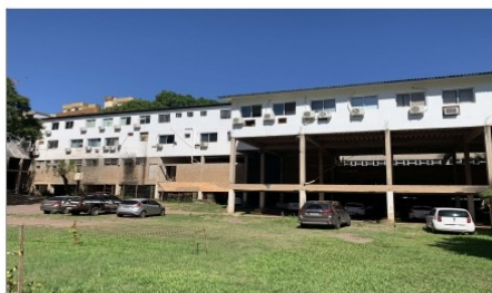
VISTA DO LOTE E EDIFICAÇÕES
